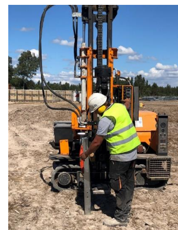
Montagem dos painéis solares
